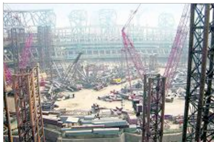
Monumental: Die Baustelle des Stadions von Herzog & de Meuron im Film.
